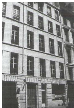
Rua de La Grange-Batelière residência da Sra Plainemaison.
