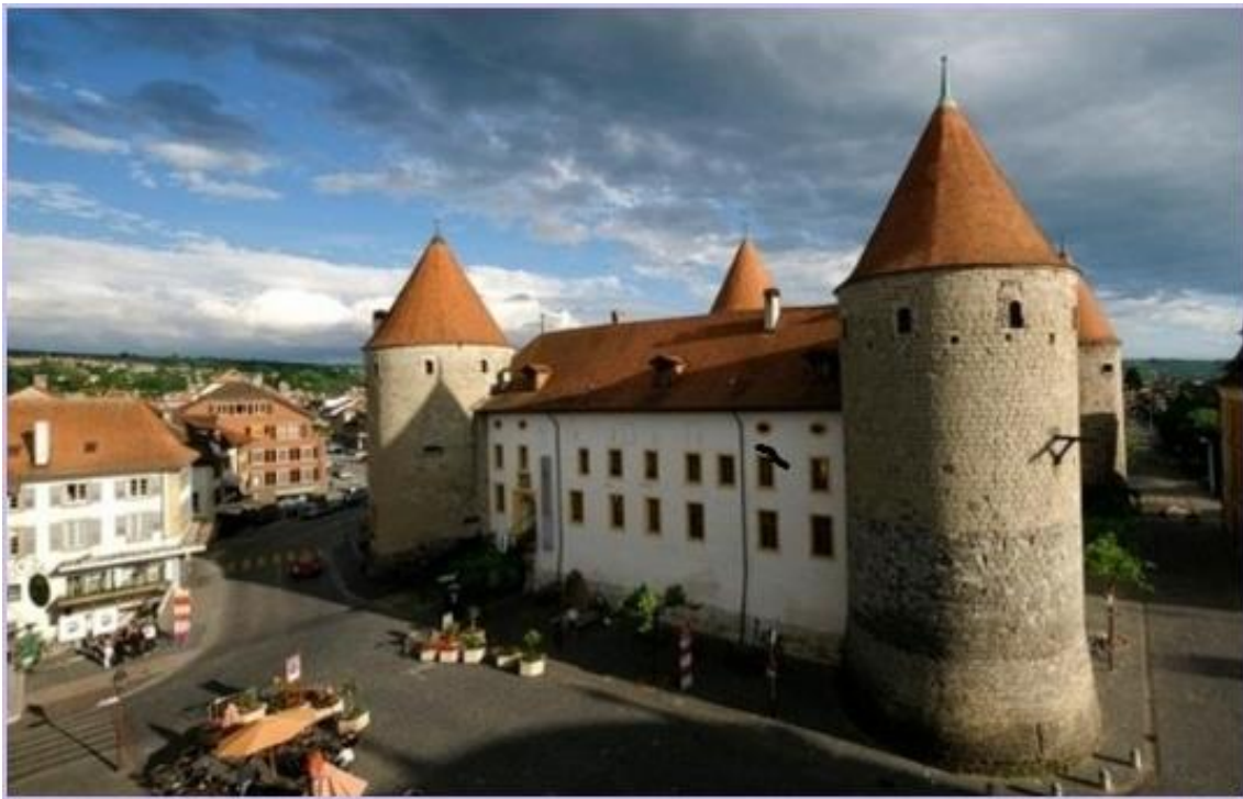
Castelo-escola de Pestalozzi em Yverdon-les-Bains, Suíça
