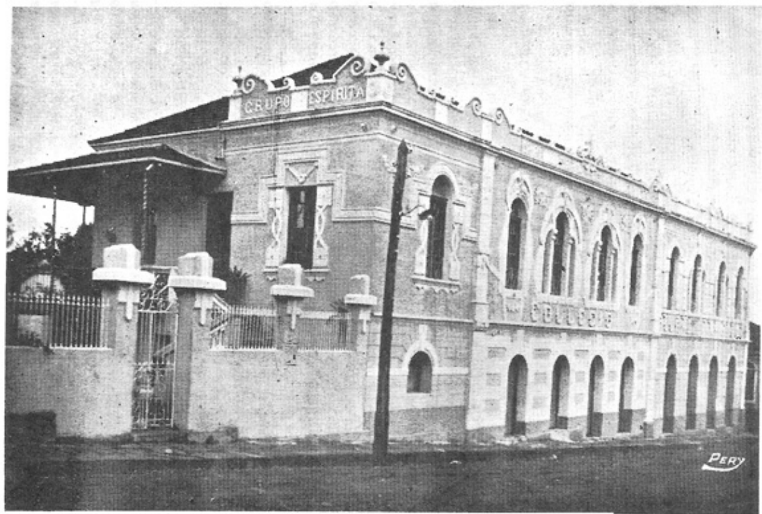
Em 1922, o prédio do Colégio Allan Kardec já havia sofrido reformas e apresentava este aspecto.
