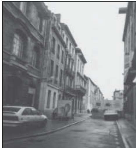
Rue Saint Siméon e, ao fundo, as obras do Metrô em 1990 Foto da Ana Suely Ferreira
