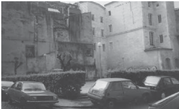
Rue Neuve, 27 – Prédio demolido – abril de 1999
