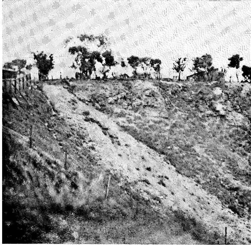
Fig. III. — Caminho para a Velha Pedreira, agora protegido por um parapeito.
